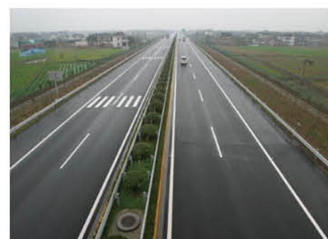
■老320国道经开区（七里湾牧场）段项目
