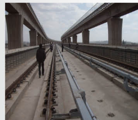
■ 昆明市轨道交通排水迁改项目
