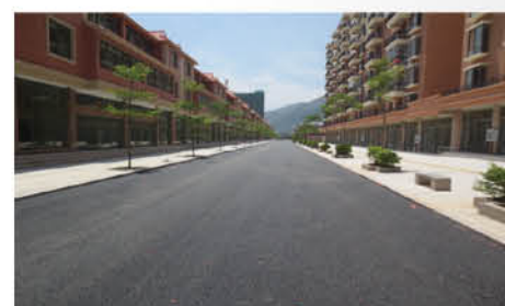
■元阳市政道路项目
