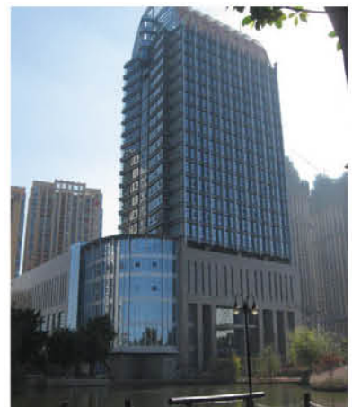
■ 龟龙湖公园配套工程项目
