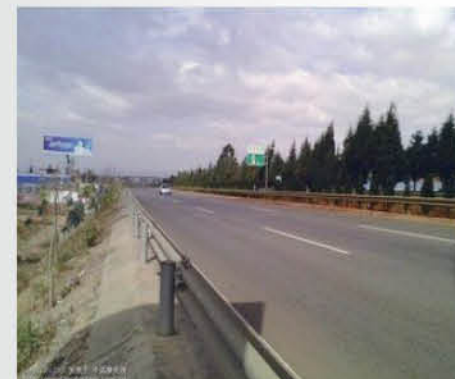
■ 建水青山路项目
