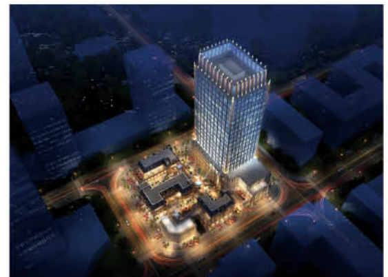
■ 中国昆明泛亚农贸物流金融中心一期工程项目
